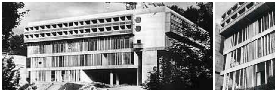
Fațada ondulatorie de la Tourette
