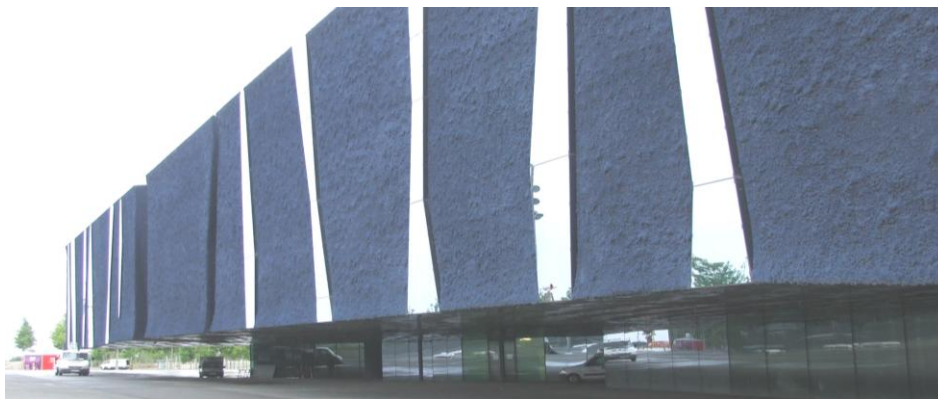
Centrul expozițional „Forum”, arh. Herzog & de Meuron, Barcelona foto: Andrei Racolța - exemplu de ritm liniar bazat pe repetiția la distanțe inegale a unui singur element.
